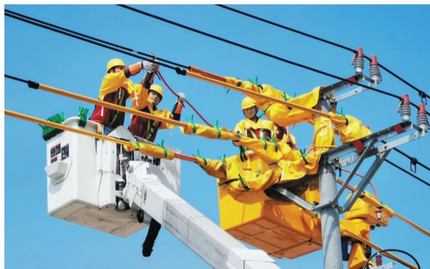
“比如一个小区里的十几栋楼,如果进行断电维修,那整个小区都要停电,带电维修只会影响出现线路故障的楼栋,其他居民的用电丝毫不受影响。”陈浩说,悄无声息地为用户维修、升级线路,是带电作业班最大的特点。
