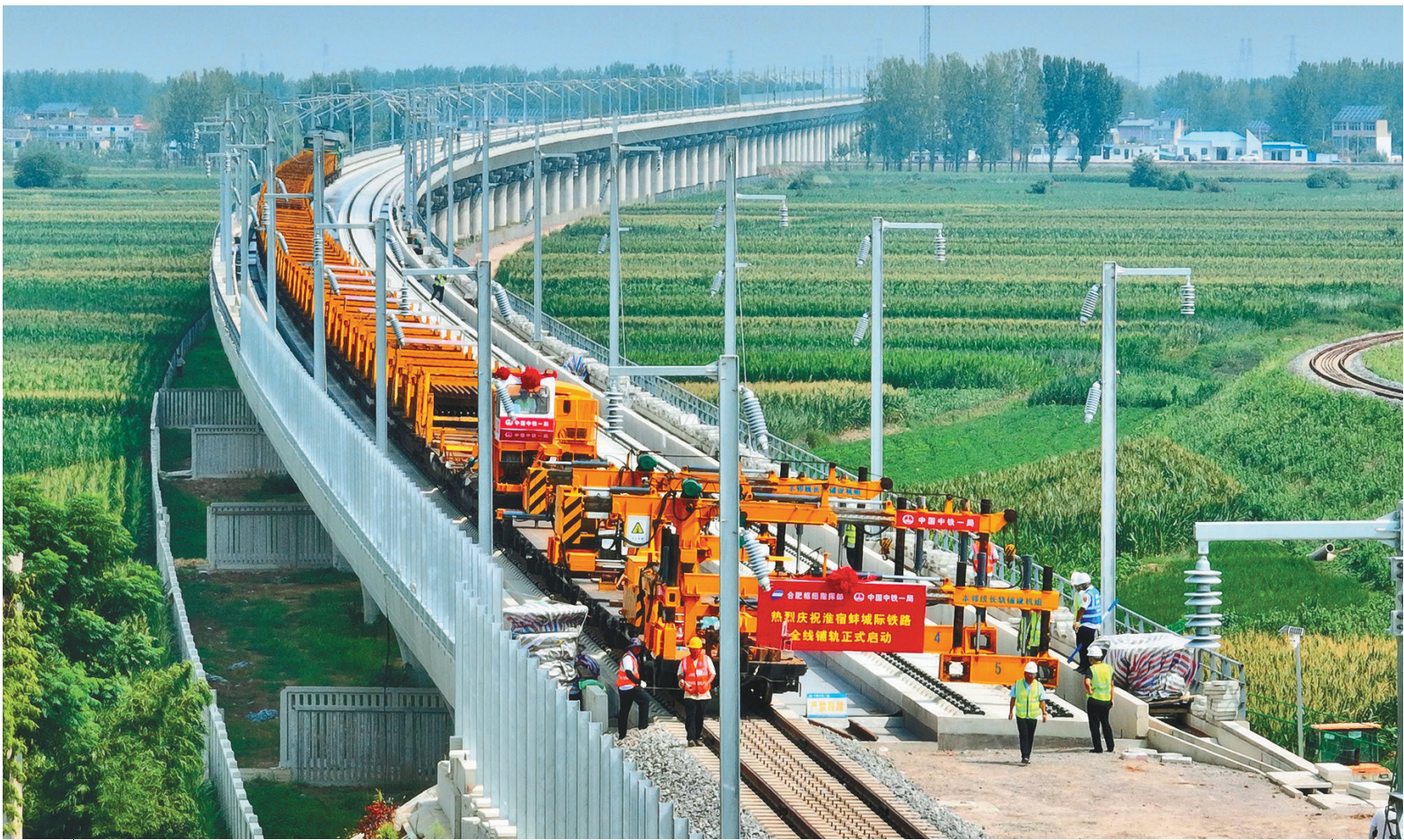
8月6日,中铁一局施工人员在淮宿蚌城际铁路铺轨施工现场作业(无人机照片)。当日,在淮宿蚌城际铁路铺轨施工现场,中铁一局施工人员将首对500米长钢轨铺设在无砟轨道上,这标志着淮宿蚌城际铁路全线开始铺轨。
