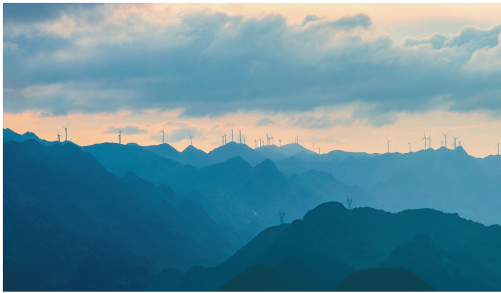
位于六盘水市钟山区梅花山的风力发电设施。近年来,贵州加快构建新型综合能源基地,建设先进煤电机组,有序发展风电、光伏等新能源产业,推动建设西南区域电力枢纽,努力构建清洁低碳、安全高效的现代化能源体系。
