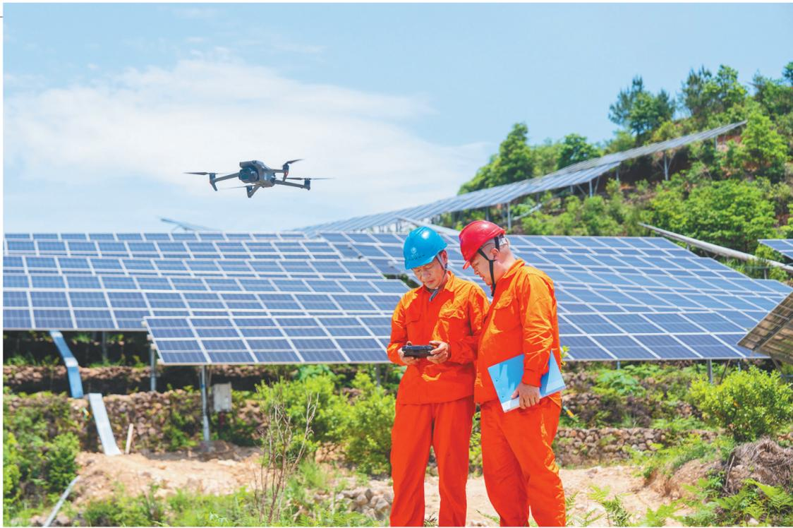
连日来,国网景宁供电公司工作人员在梧桐乡和尚尖9.35兆瓦农光互补光伏项目现场,通过“无人机+人工巡查”等手段开展精细化巡检,及时消除安全用电隐患,有效提升光伏项目的运行可靠性,为项目的持续稳定发电和当地绿色能源产业的健康发展提供坚实保障。记者 陈炜 通讯员 季维娜 摄
