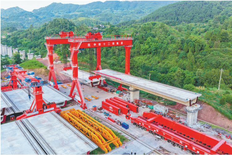
7月5日,渝万高铁江林村特大桥架梁施工作业现场,架梁机械在架设预制箱梁(无人机照片)。
