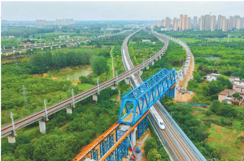
新建沪宁合高铁钢桁梁跨越沪蓉铁路(6月15日摄，无人机照片)。6月15日凌晨，由中铁四局承建的新建上海至南京至合肥高铁重达近千吨的钢桁梁成功跨越沪蓉铁路，为后续架梁施工奠定基础。
