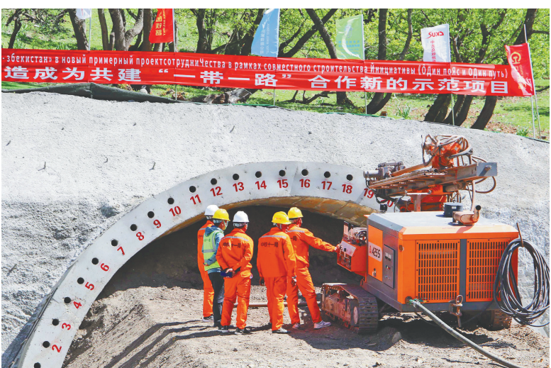
2025年4月29日,工作人员在吉尔吉斯斯坦贾拉拉巴德地区的中吉乌铁路重点控制性工程开工现场忙碌。 新华社发(罗曼 摄)
