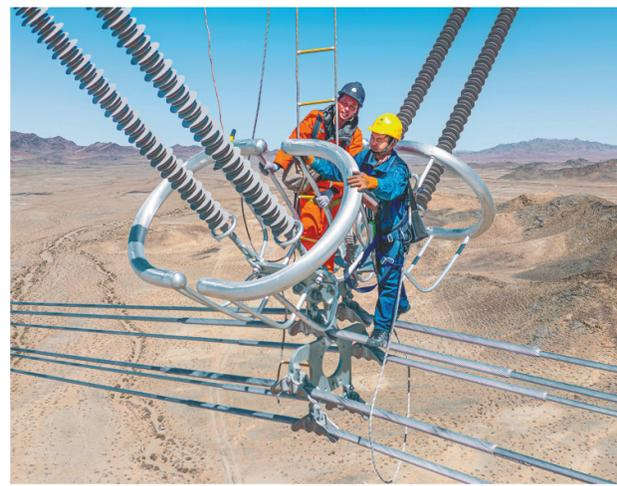
在新疆哈密市,电力员工在哈密—重庆±800千伏特高压直流输电线路对均压环进行检查验收(4月13日摄,无人机照)。
