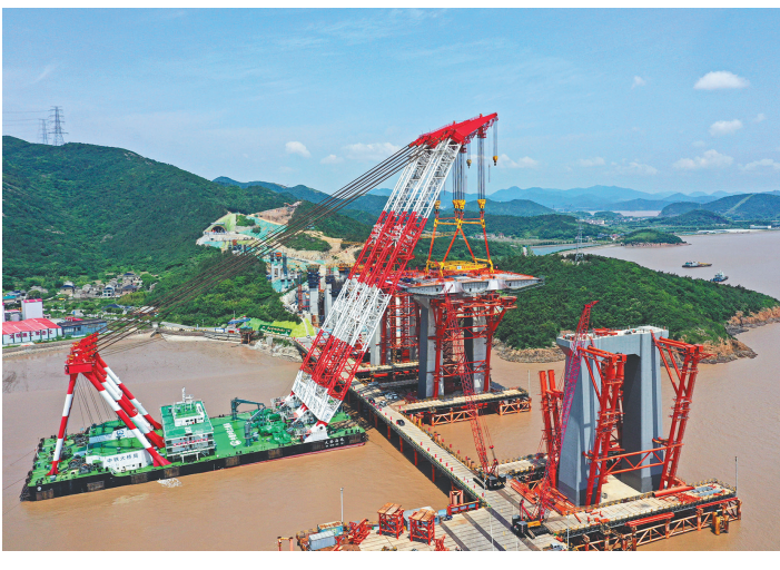
5月27日,在甬舟铁路西堠门公铁两用大桥建设现场,中铁大桥局“大桥海鸥”号起重船将节段钢梁吊装到指定位置(无人机照片)。
