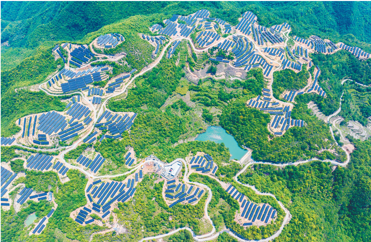
近日,景宁梧桐乡和尚尖光伏电站正式并网发电,作为本地企业投资规模最大的地面光伏项目,它的启动标志着该县县域新能源产业迈入规模化、集约化新阶段。电站投运后,每年可创收约450万元,减少1.2万吨二氧化碳排放,相当于种下6.7万棵生态树,省下4800吨标准煤,成为实现“双碳”目标的有力注脚。
