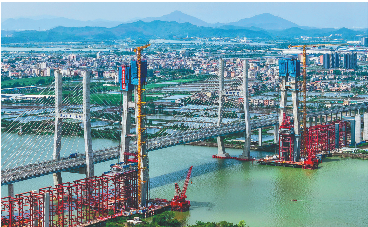
5月11日,深江铁路跨磨刀门水道主桥东主塔(左二)封顶(无人机照片)。当日,中铁建大桥局承建的深江铁路关键性工程跨磨刀门水道主桥东主塔封顶。该桥横跨中山和江门两市交界的西江磨刀门水道,为140米高墩大跨斜拉桥。
