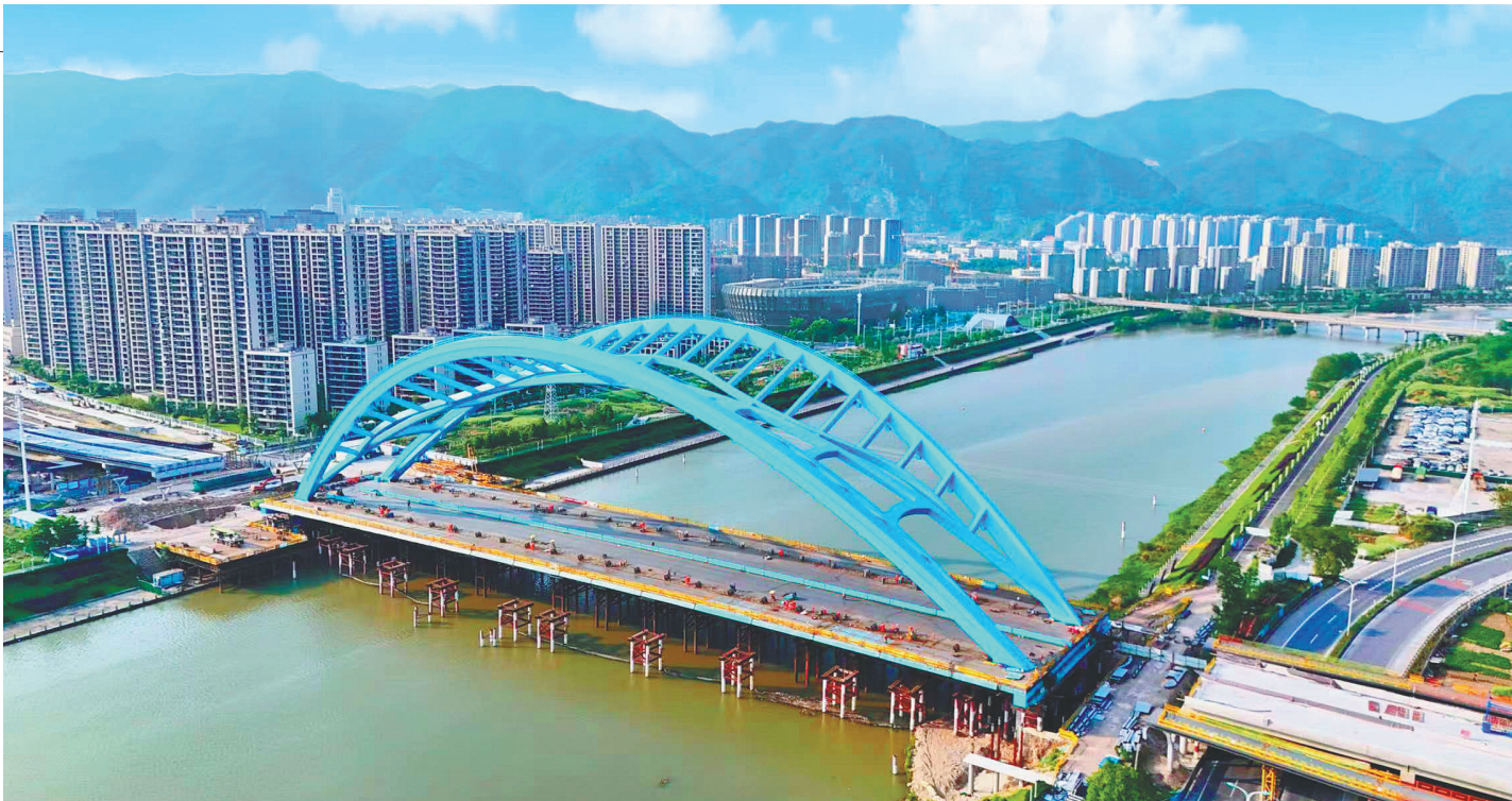
近日,丽水市城市风廊及配套设施(东地路南延伸段)项目拆除了主、副拱支架,主跨208米的钢结构蝴蝶形拱桥主体已初具雏形。项目计划于今年底基本完工,建成后,将加强水东与城区之间的连接,推动城市一体化发展。 记者 陈炜 麻东君 通讯员 陈星吟 摄
