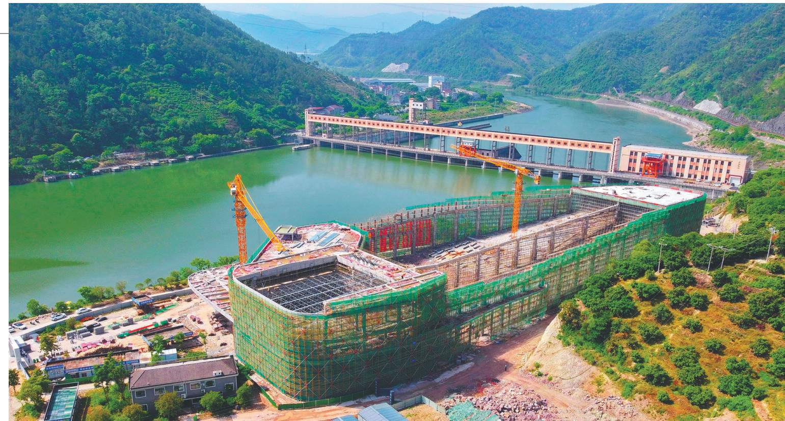
近日，南明湖冰雪大世界项目实现主体结构封顶，砌体与屋面网架工程正有序推进。该项目位于莲都区开潭村，总建设用地面积约180亩，总投资额约25亿元，涵盖室内冰雪馆、度假酒店等多元业态，预计今年10月正式运营，将为广大市民游客带来全新的冰雪旅游体验。 记者 麻东君 陈炜 通讯员 汪晓 摄
