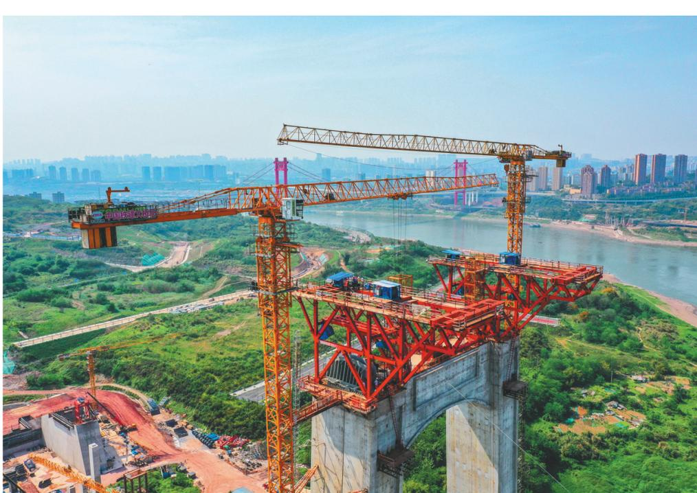
这是4月19日拍摄的重庆黄桷沱长江大桥先导索架设作业现场(无人机照片)。
