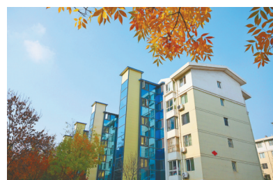
2024年10月31日拍摄的正在加装电梯的银川市兴庆区燕和园小区。新华社发(袁宏彦 摄)
