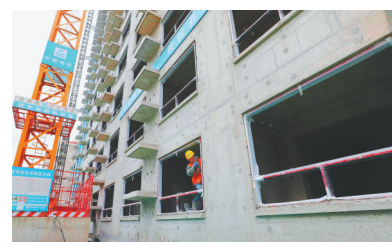
2024年3月15日,工人在上海市静安区谈家桥城市更新项目工地安装窗户框架。新华社记者 方喆 摄
