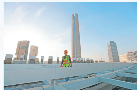
这是2023年11月22日在埃及开罗以东的埃及新行政首都中央商务区拍摄的一名在高楼楼顶施工的中国工人。 新华社记者 隋先凯 摄
