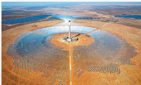
这是2024年8月20日在南非北开普省拍摄的由中国电建集团山东电建三公司承建的南非红石100兆瓦塔式熔盐光热电站项目(无人机照片)。 新华社记者 张誉东 摄
