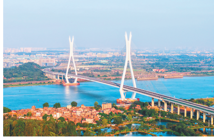
这是11月21日拍摄的富龙西江特大桥(无人机照片)。由中交路桥建成的富龙西江特大桥将于11月22日通车。富龙西江特大桥西起佛山高明区,东至佛山三水区,全长1770.6米,主桥为双塔双索面组合梁斜拉桥。新华社记者 刘大伟 摄
