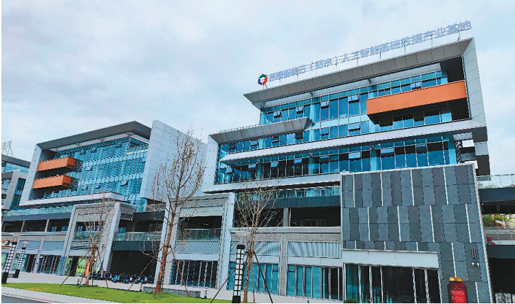
图为百度智能云(丽水)人工智能基础数据产业基地。
