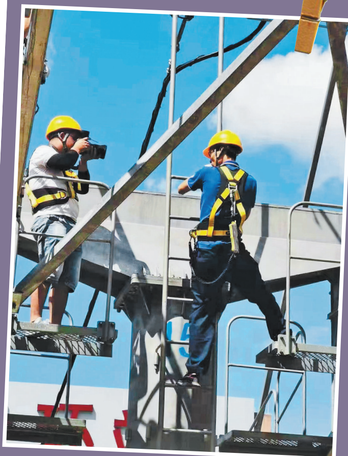
2021年7月,户外温度近40℃。为记录高温下的索道检修工,云和融媒体中心记者梅明益,在午后2时爬上近20米高的检修支架。戴着闷热的安全帽,系着笨重的安全带,他站在摇晃、滚烫的支架上,坚持拍摄两个多小时。
