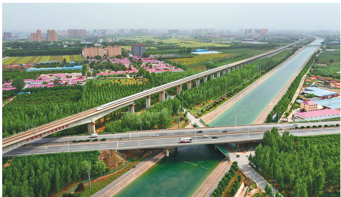
在河北省石家庄市正定县以北的于家庄村附近,南水北调中线干渠与高铁、公路交织。
