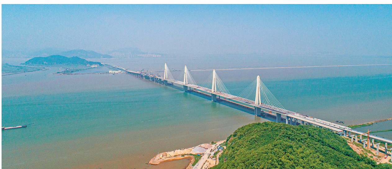
珠机城际金海特大桥全景(9月5日摄,无人机照片)。
