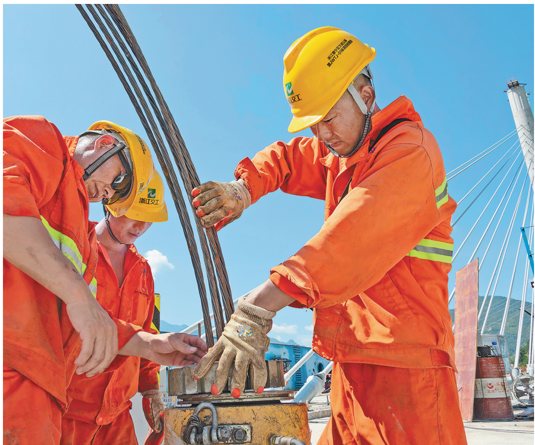
工人在景文高速公路景宁高架建设工地进行挂篮下放操作。时下,景宁进入持续晴热高温天气,在建的景(宁)文(成)高速公路建设工地上,施工人员通过错峰施工抢抓工程进度,确保今年年底顺利通车。景文高速公路是浙江省大通道建设的十大标志性工程之一,全长68公里,桥隧比高达80%,总投资137亿元,沿线地面高程在50至1000米之间,有“浙南天路”之称。
