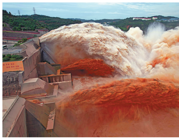
2021年10月10日拍摄的黄河小浪底水库泄洪场景。
