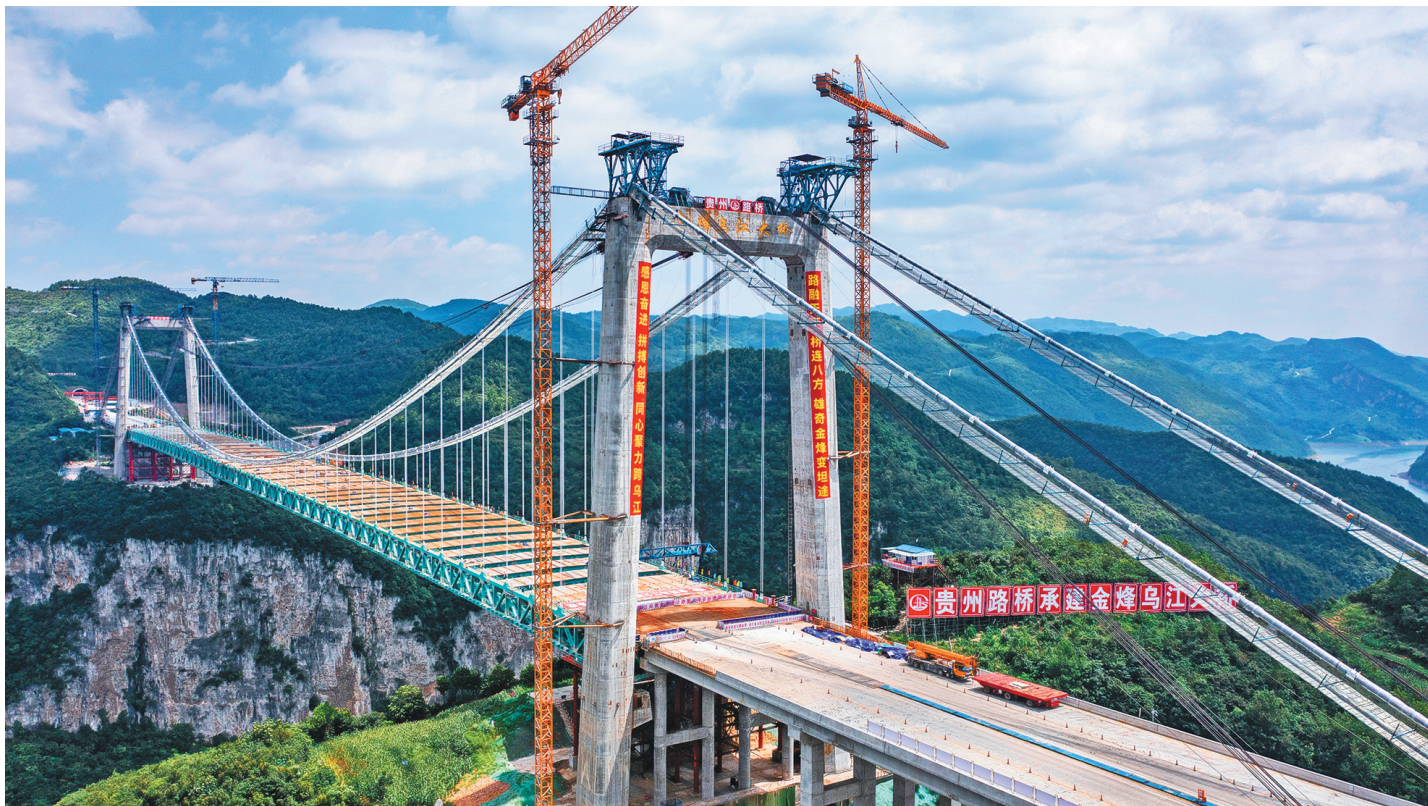
7月10日拍摄的金烽乌江大桥合龙现场(无人机照片)。
