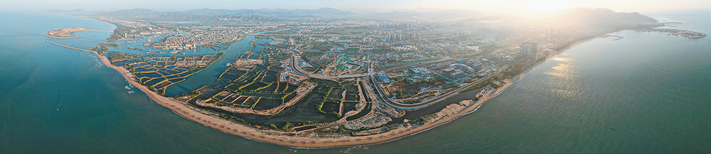
正在建设中的崖州湾科技城。
