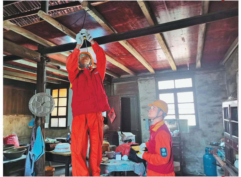
检修老旧线路并安装新的电灯。
