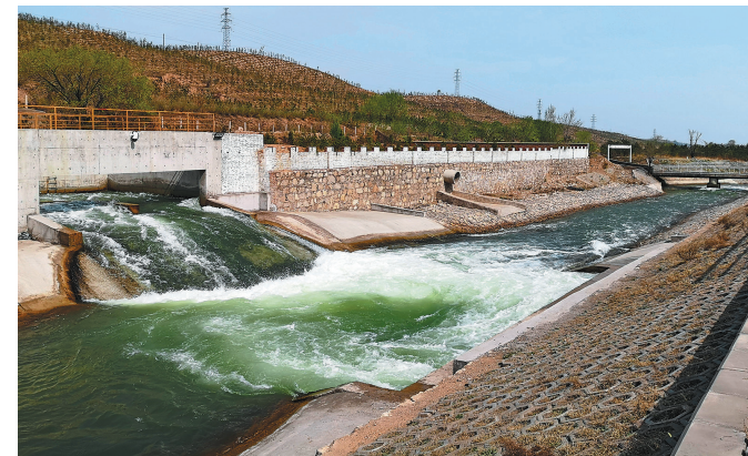
这是位于山西省朔州市平鲁区的万家寨引黄工程北干线1号隧洞。
