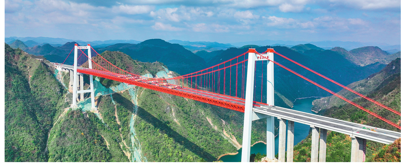
11月30日在贵州省贵定县拍摄的进行静态荷载试验的阳宝山特大桥(无人机照片)。 当日,贵黄高速公路控制性工程阳宝山特大桥开始进行静态荷载试验,48辆满载共计1680吨货物的大型货车停放在桥上,以检验桥梁结构整体的施工质量与受力性能,为桥梁交(竣)验收、通车安全提供重要的科学依据。 新华社传真
