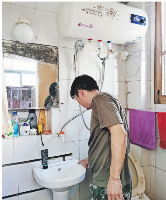
热水器和洗手台安装完毕
