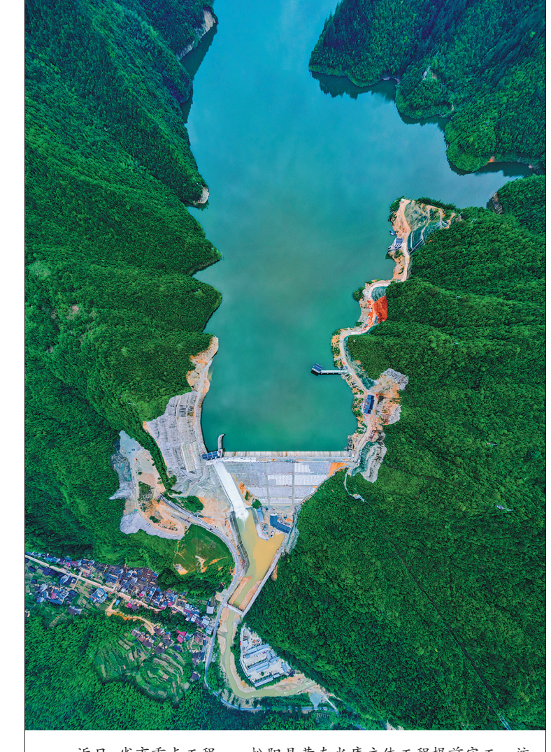
近日,省市重点工程——松阳县黄南水库主体工程提前完工。该水库是一座以供水、灌溉、防洪为主,兼顾发电、改善水生态环境等功能的准大型水库,工程初设概算批复总投资18.1亿元,集雨面积207.8平方公里,总库容9196万立方米,总装机1.64万千瓦。水库建成后,每年可新增供水能力6000余万吨,彻底解决松古平原“北枯南涝”的水资源瓶颈和17万亩农田的灌溉问题。
