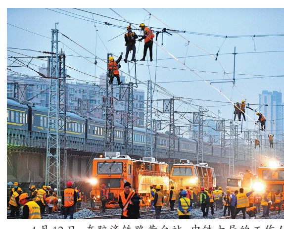
4月12日,在胶济铁路黄台站,中铁十局的工作人员在进行胶济铁路至济青高铁联络线黄台站改造施工作业。 当日,经过6个小时的封锁要点施工,中铁十局涵盖工务、信号、通信、信息、电力、电率6个专业的千余名工作人员,圆满完成胶济铁路至济青高铁联络线黄台站改造施工作业。黄台联络线建成后,将实现济南西站、济南站、济南新东站的互联互通,京沪高铁、石济客专、济青客专和济青高铁实现牵手成网。
