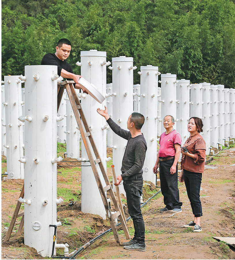
近日,云和县浮云街道云章村村民叶克敏正在农田里进行气雾栽培管道建设施工。该项技术是无土栽培技术的新发展,利用喷雾装置将营养液雾化,直接喷施于植物根系,让蔬菜种植更科学。今年,叶克敏在政府的大力扶持下,将“气雾栽培”引入蔬菜种植,打开了增收新路子。
