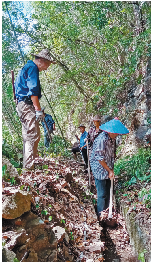
日前,龙泉市住龙镇龙星村党支部组织村民抗旱保丰收,对该村500米长的水渠进行人工清污处理。
