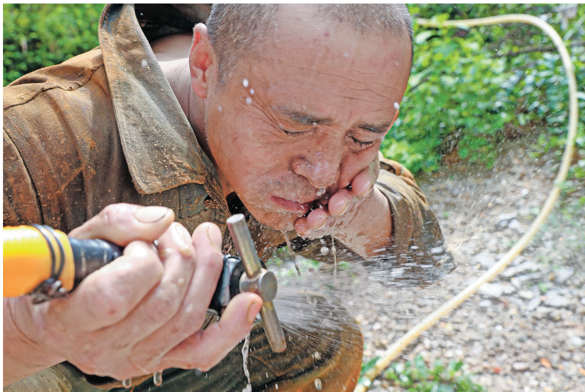
7月24日,在位于贵州省铜仁市玉屏侗族自治县的西南水泥熟料生产线建设施工现场,一名工人洗脸消暑。
