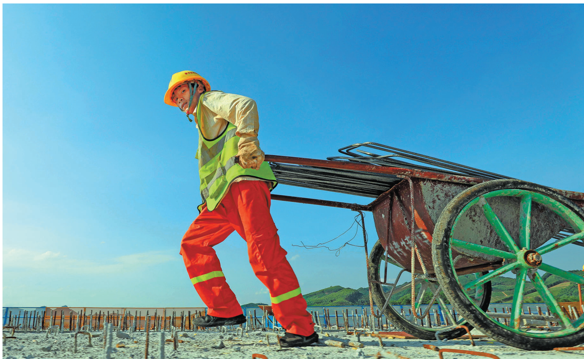
7月23日,在融河高速广西柳州市融安县融江大桥建设工地,一名工人在运送钢筋。
