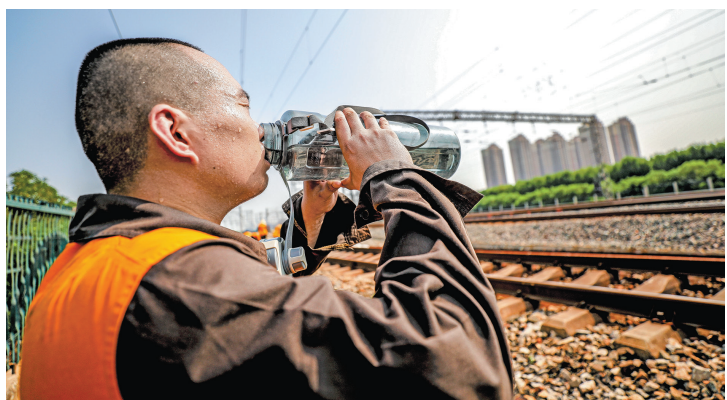
7月30日,天津工务段职工在检修间隙喝水休息。夏日炎炎,中国铁路北京局集团有限公司天津工务段职工不畏酷暑,坚守岗位,对北塘站内钢轨进行检修,发现状况及时更换“病害钢轨”。
