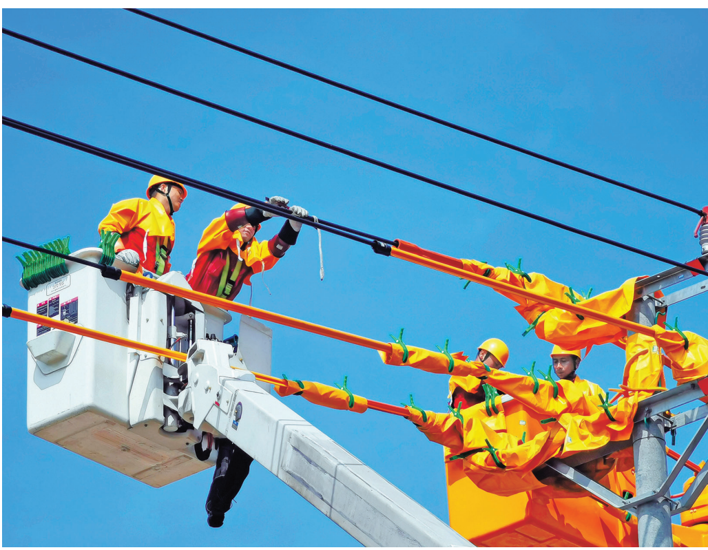
近日,国网丽水市莲都区供电公司带电作业班人员在10千伏竹溪A276线56号杆双回路直线杆改耐张、新增开闭所环网电缆引接线搭接工作,通过线路改接,提高该段线路供电可靠性。作业当天,该公司共出动绝缘斗臂车2辆,10余名带电作业骨干人员顶着烈日高温,经过8小时的紧密配合和不间断作业,顺利完成了所有的工作,确保了万洋智造小镇竹溪A276线沿线所有工厂生产生活正常用电。 记者 雷宁 通讯员 吴爱玲 摄
