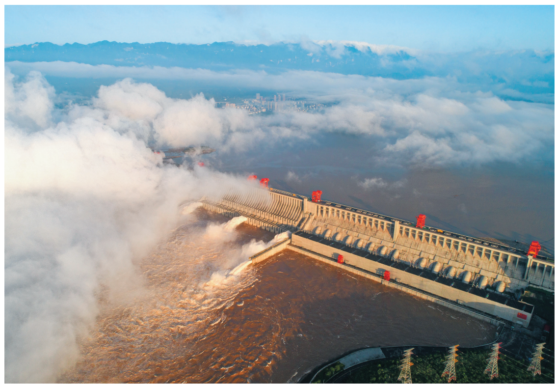
7月27日,长江三峡枢纽工程开闸泄洪深孔泄洪(无人机照片)。7月26日14时,受长江上游强降雨影响,三峡水库入库流量达50000立方米每秒,迎来长江2020年第3号洪水,27日14时洪峰流量达到60000立方米每秒,拦洪削峰达36.7%。
