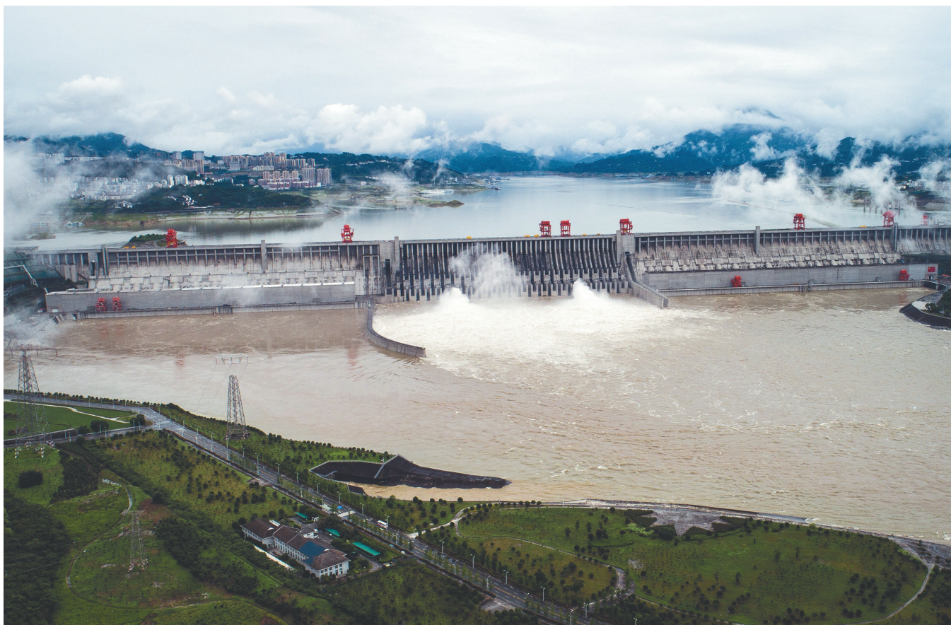
6月29日,三峡枢纽开启泄洪孔泄洪。
