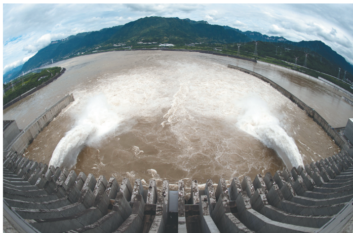
6月29日,三峡枢纽开启泄洪孔泄洪。
