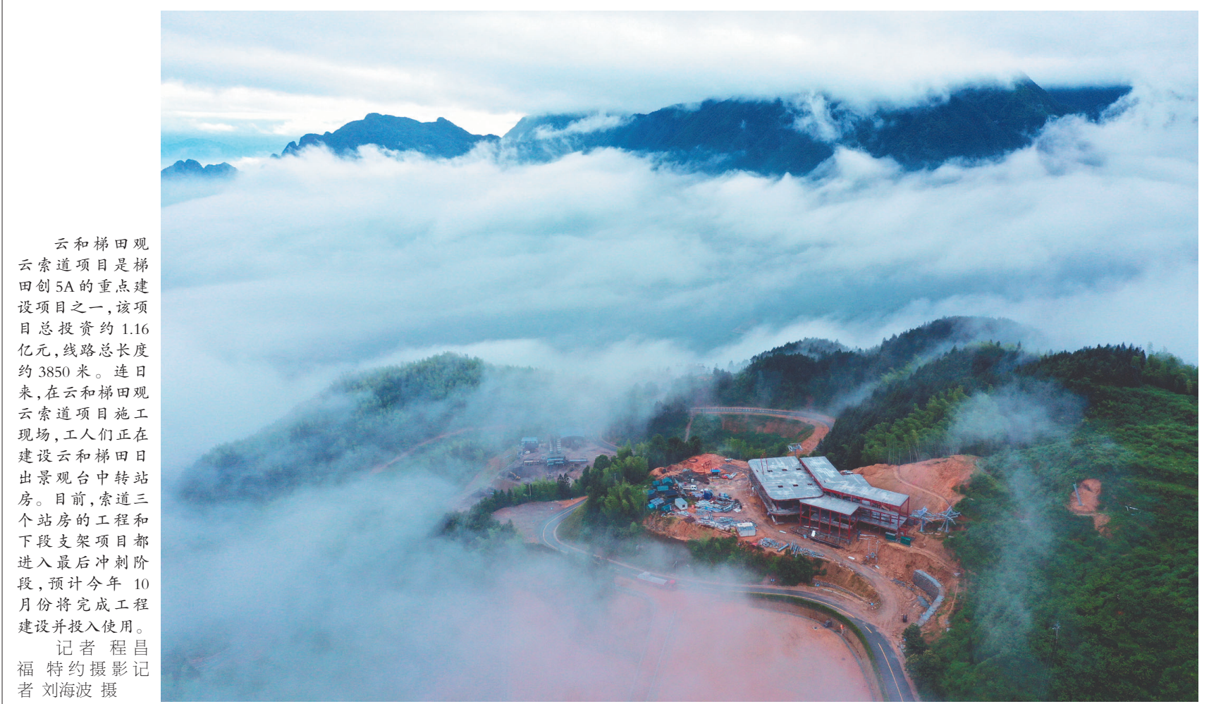
云和梯田观云索道项目是梯田创5A的重点建设项目之一,项目总投资约1.16亿元,线路总长度约3850米。连日来,在云和梯田观云索道项目施工现场,工人们正在建设云和梯田日出景观台中转站房。目前,索道三个站房的工程和下段支架项目都进入最后冲刺阶段,预计今年10月份将完成工程建设并投入使用。
