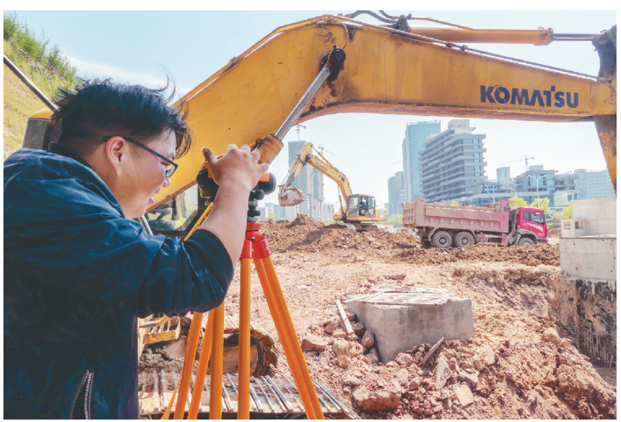
近日,莲都区城北街与教工路口,省重点项目华东药用植物园(丽水植物园)建设工地热火朝天。为夺回前期受疫情影响而耽误的时间,施工队加班加点开展作业。 记者 程子齐 通讯员 於慧彪 摄
