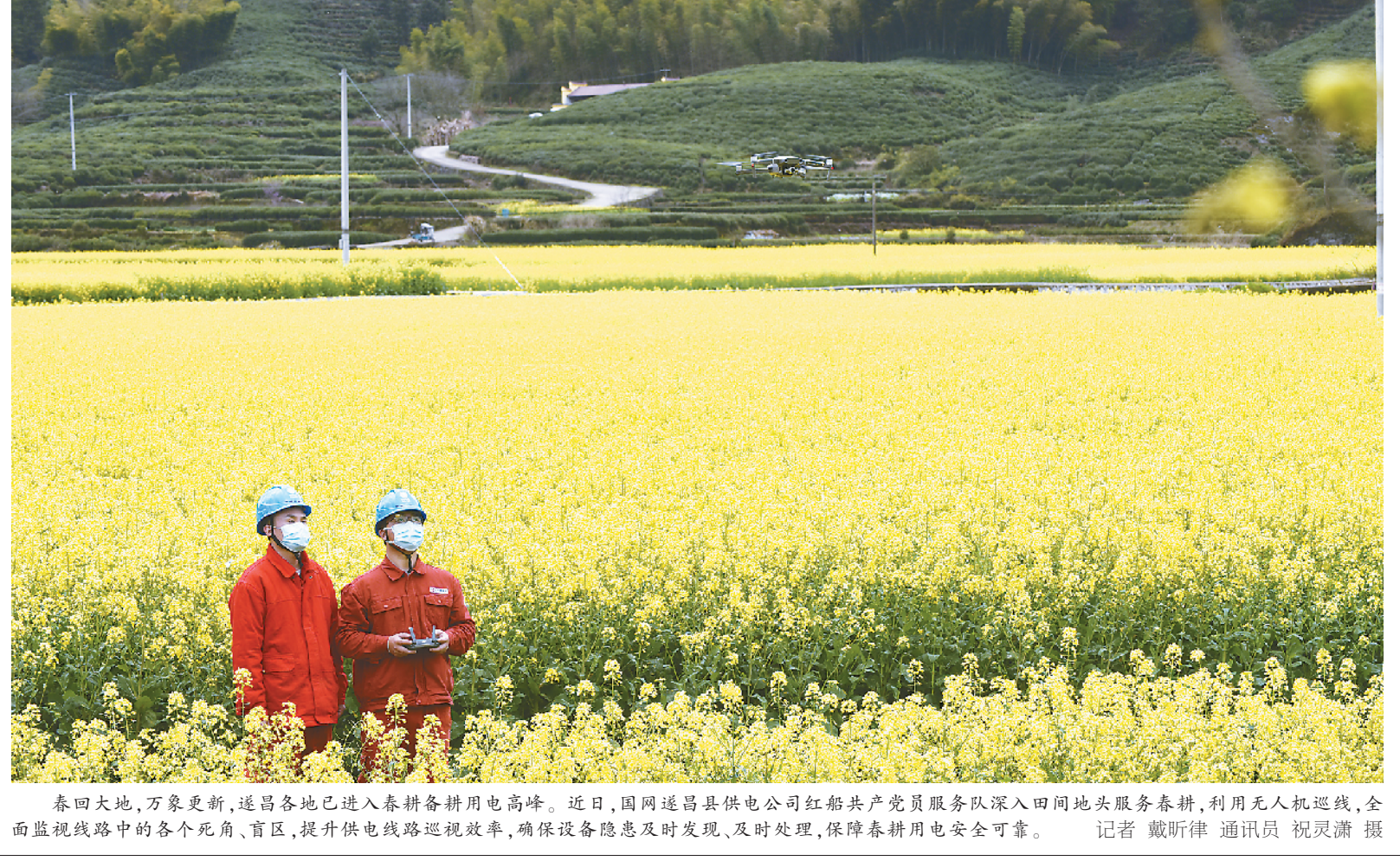
春回大地,万象更新,遂昌各地已进入春耕备耕用电高峰。近日,国网遂昌县供电公司红船共产党员服务队深入田间地头服务春耕,利用无人机巡线,全面巡视线路中的各个死角、盲区,提升供电线路巡视效率,确保设备隐患及时发现、及时处理,保障春耕用电安全可靠。 记者 戴昕律 通讯员 祝灵潇 摄
