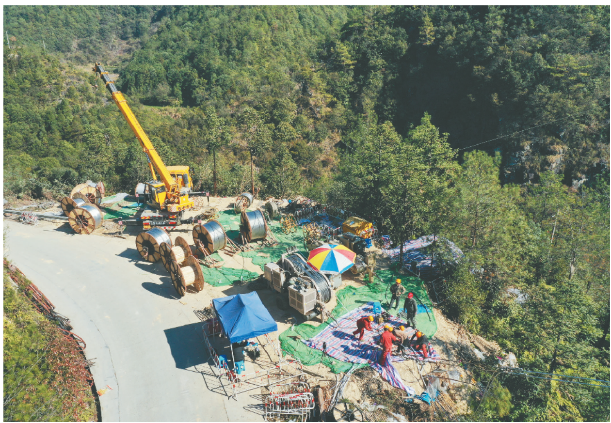
近日,中国能建华东建设浙江火电承建的水西南电网220千伏补强工程正在紧张施工中。该工程新建线路长度66.042公里,途经莲都、云和、景宁三个县(区)。新建铁塔77基,更换OPGW光缆长度14公里,计划2020年4月投产。图为位于云和元和街道梅湾村工程施工现场。特约摄影记者 刘海波 摄
