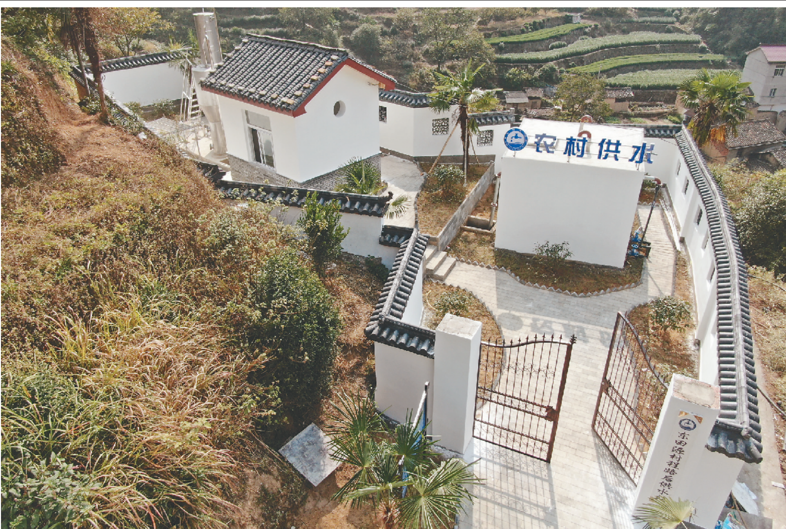
农村饮用水工程作为省市县的民生实事项目,松阳县明确时间节点,狠抓责任落实,推进“美丽农村水厂”建设。今年松阳县共安排85个农村饮用水达标提标工程项目,努力实现农村从“有水喝”到“喝好水”的转变。图为该县象溪镇东田源村程路后自然村“美丽水厂”,与整个松阳田园环境相协调,成为美丽松阳一景。
