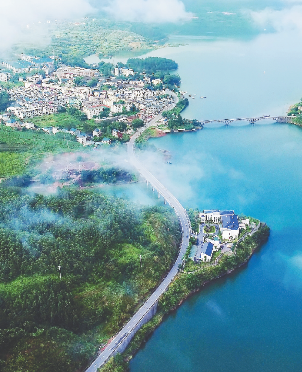
遂昌县按照全省“四好农村路”建设“四个全国领先”和创建示范县的目标要求,改造创建了峡北线(峡口门至应村)、湖大线(湖山至大溪边)等多条四级县道公路。
