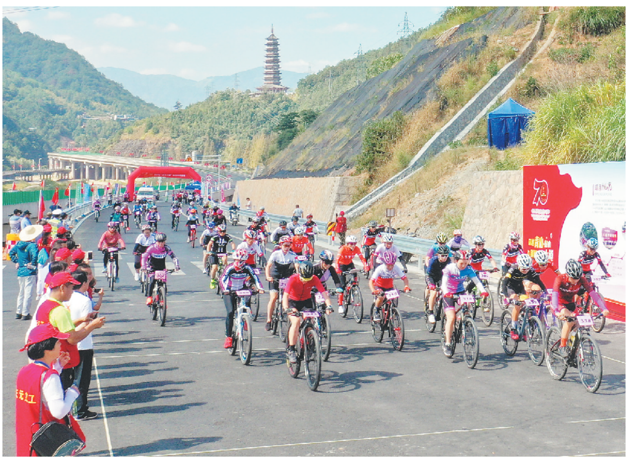
9月30日上午,庆元县庆元大道翔龙隧道路口至洋心段全线贯通,全长7公里的庆元大道(过境段)历时41个月完工,其建成通车标志着庆元大道全线开通,真正实现了全县一级公路“零”的突破。
