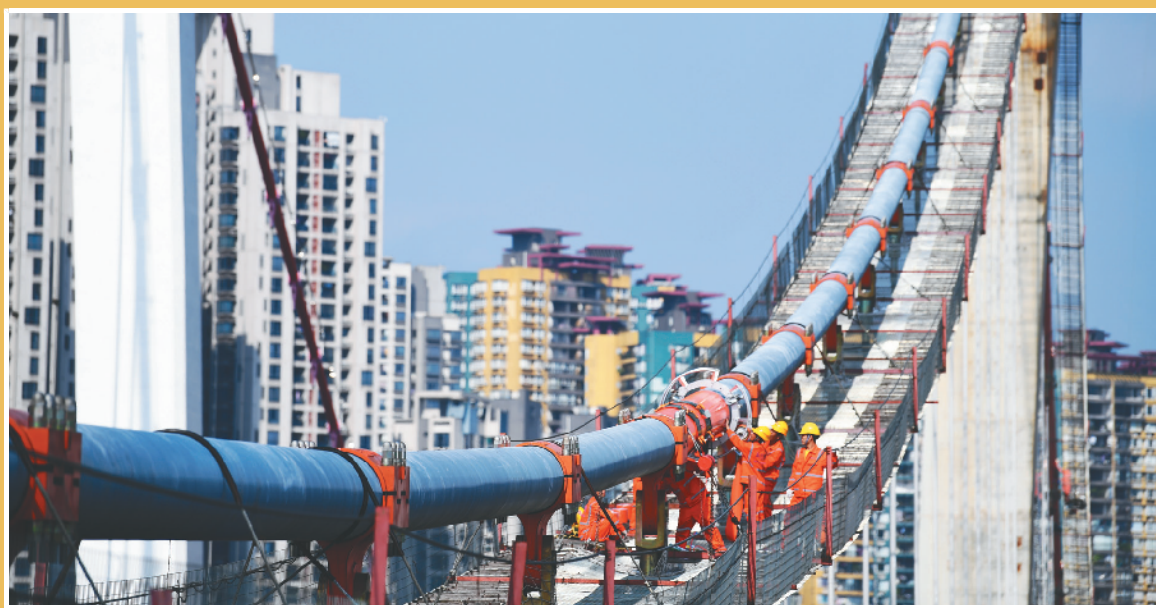
7月9日,工人在重庆鹅岩轨道专用桥施工现场作业。
