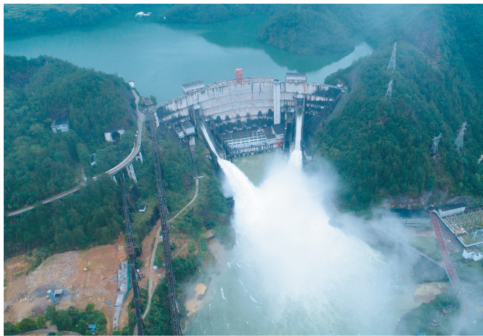
我市连日暴雨,据气象台预报,近期还将有强降雨过程。为后续腾出库容,昨日16时30分,紧水滩水库开闸预泄,最大下泄流量为1000立方米每秒。 记者 程昌福 通讯员 刘海波 陶萱 摄
