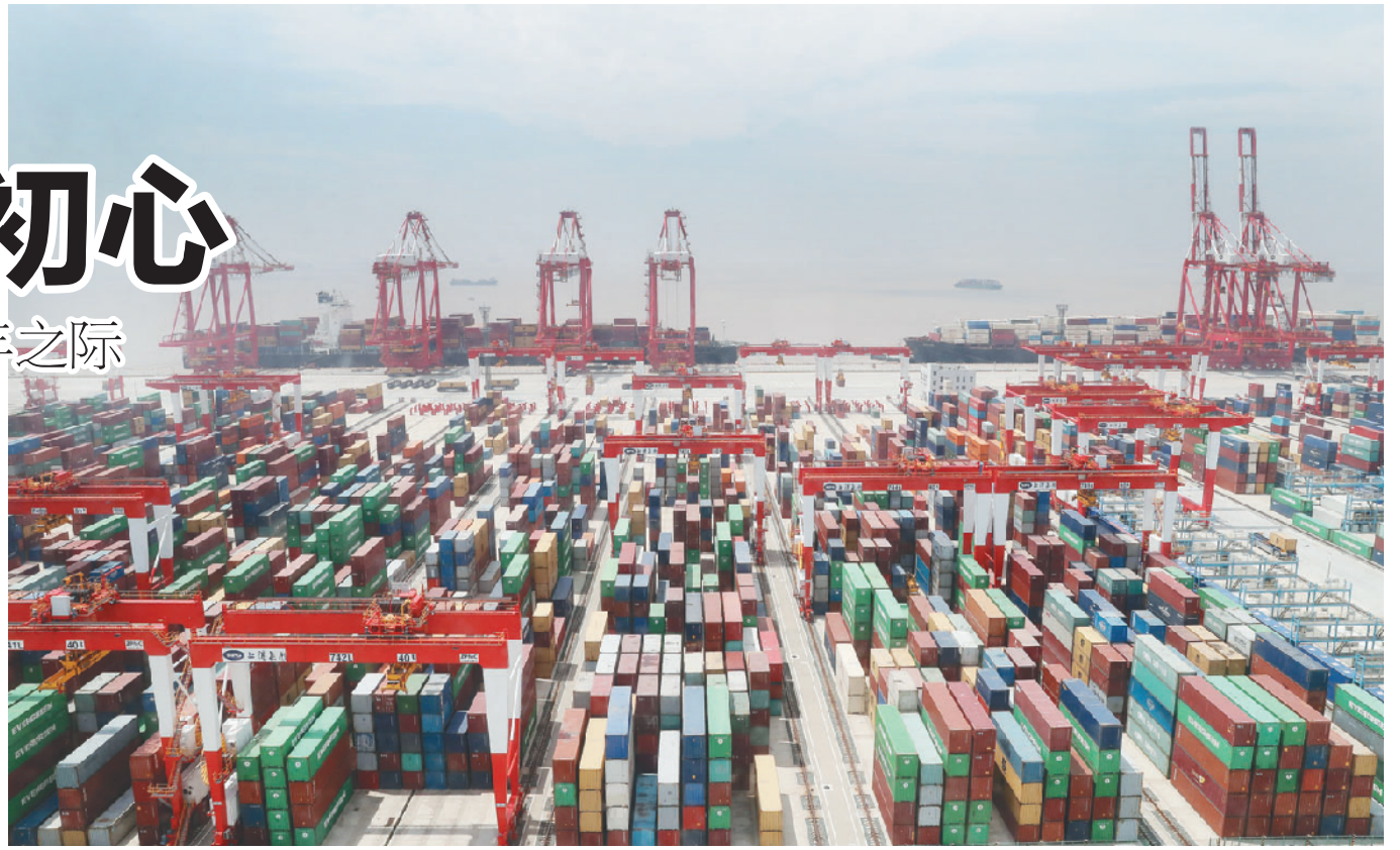
这是从控制塔上俯瞰上海洋山港四期无人码头。
