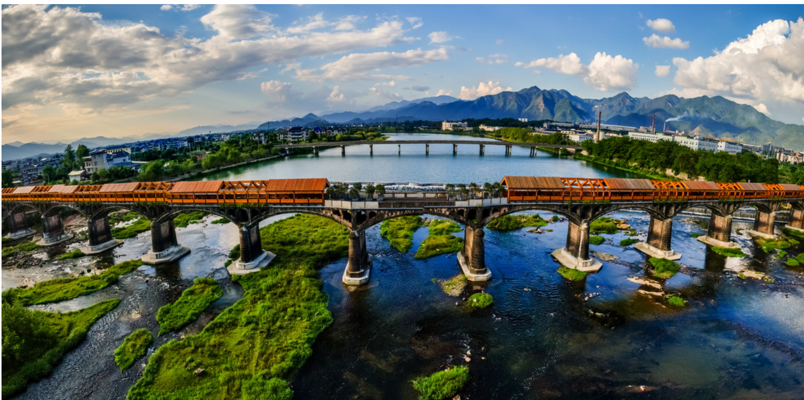
松阳松阴溪景区有一座“网红桥”——石门圩廊桥。据了解,该桥原建于1974年,为混凝土双曲拱桥,全长263米,连接两岸的石门村和石门圩两个村庄。2016年,当地政府聘请设计师,将其改造成木装结构的廊桥,并加入了许多时尚元素。上月,松阴溪景区获评4A级景区,石门圩廊桥也随之在网络上走红,春节期间吸引了众多游客前来游览。
