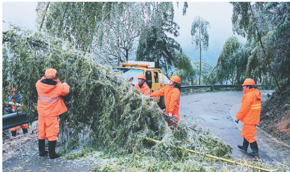
近日,气温骤降,遂昌县高海拔地区出现降雪和冰冻。12月9日,在通往黄沙腰镇的大风岭路段出现不同程度的冰雪,该县公路部门及时派出应急抢险队伍,清除道路上被冰雪压倒的毛竹,确保道路安全畅通。
