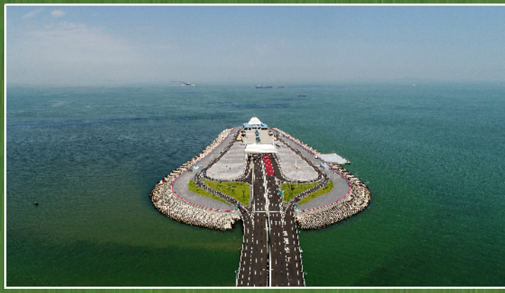
从港珠澳大桥东人工岛遥望西人工岛,中间是海底隧道(2018年7月11日无人机拍摄)。
