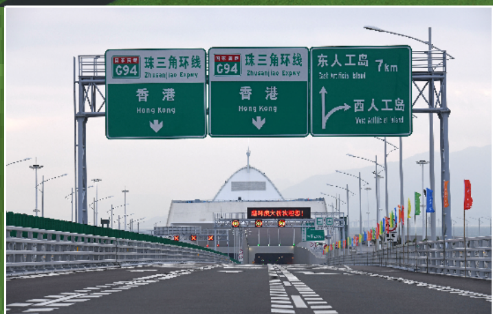
港珠澳大桥西人工岛隧道口(2018年10月20日摄)。
