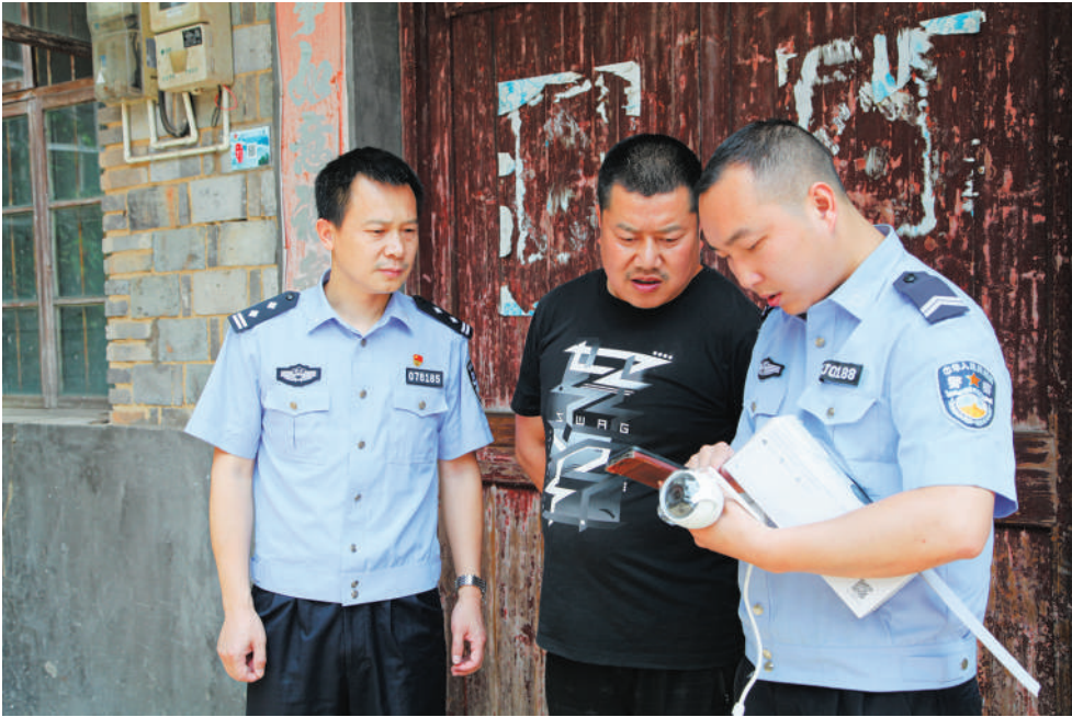
派出所民警上门安装视频监控 谢遥遥 摄
